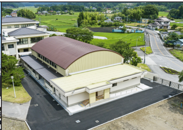
篠井小学校屋内運動場長寿命化改修工事
