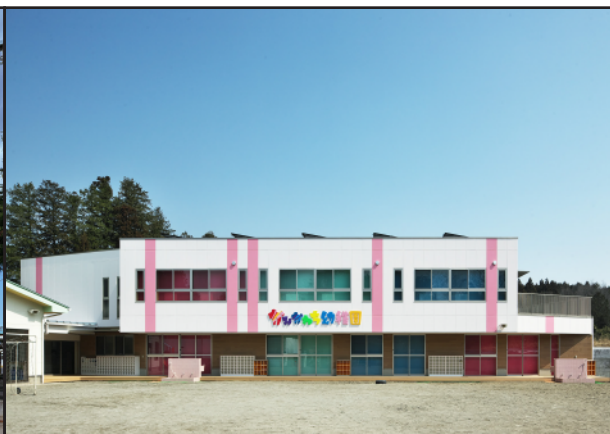
上河内幼稚園改築工事
