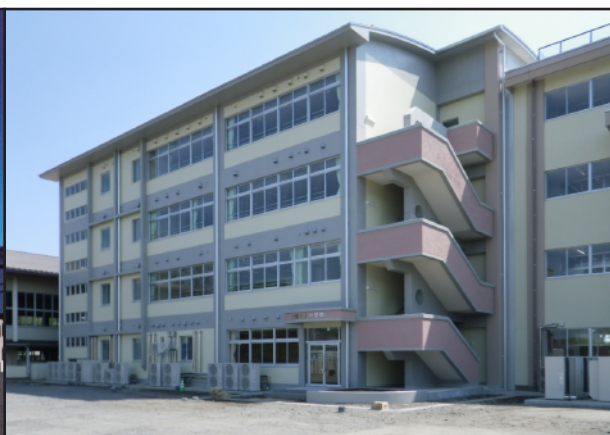
清原中央小学校改築耐震補強・大規模改造工事
