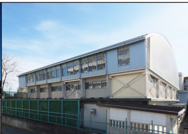
一条中学校屋内運動場耐震補強工事
