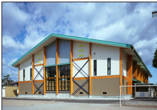
陽東小学校屋内運動場改築工事
