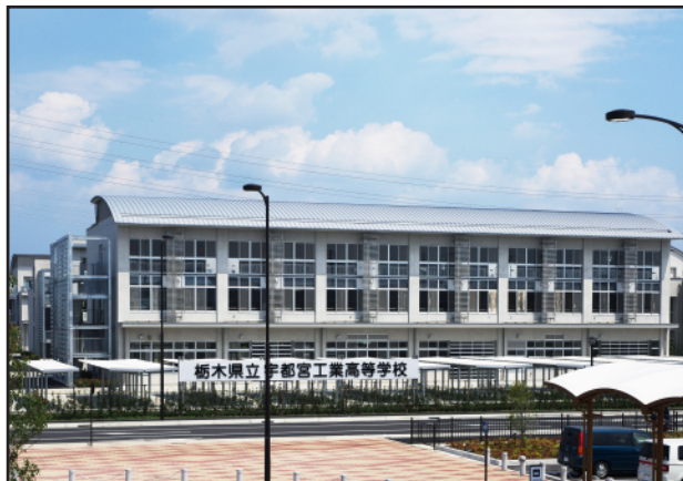
栃木県立科学技術高等学校（仮称）実習棟その1新築工事
