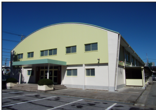
今泉小学校耐震補強その他工事
