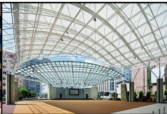
オリオン市民広場屋根増築その他改修工事
