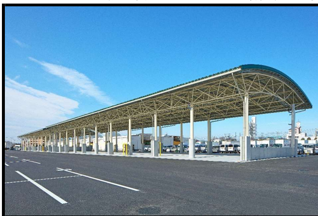
中央卸売市場青果仲卸業者荷捌き所新築工事
