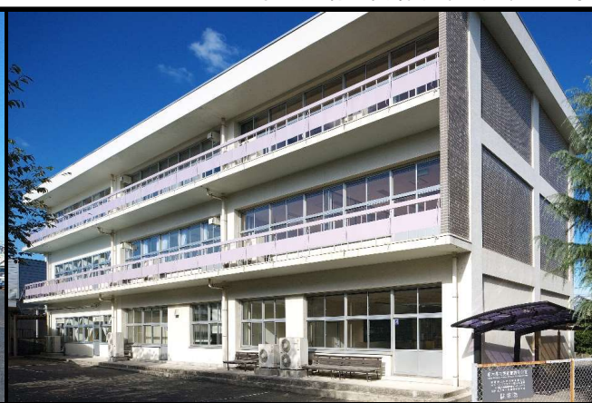
県立美術館普及分館耐震改修工事
