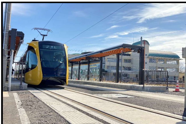
平石中央小学校前停留場新築工事
